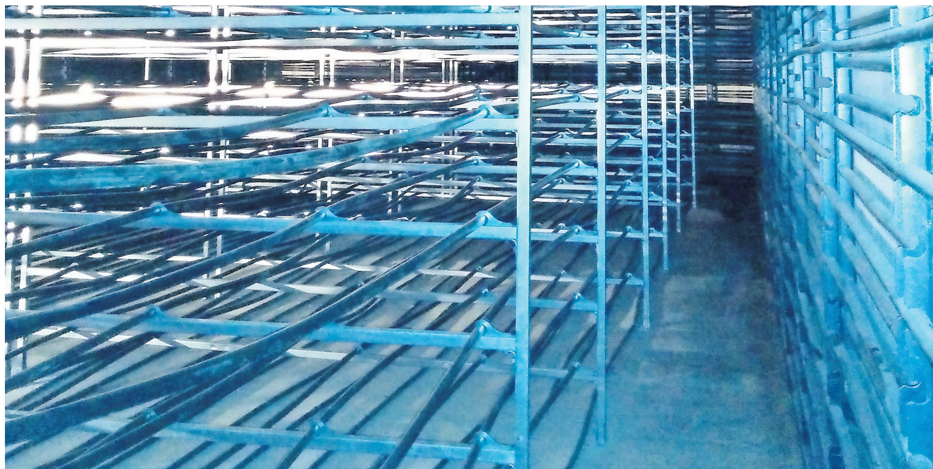
Der 800 Kubikmeter fassende Eisspeicher: Ist hier etwas defekt, kann nur ein speziell ausgebildeter Industrietaucher Reparaturen ausführen – wenn das Wasser nicht gefroren ist. Die aufwendige Technik ist ein Gewinn für das Unternehmen Sennheiser und für die Umwelt. Sennheiser (2)
